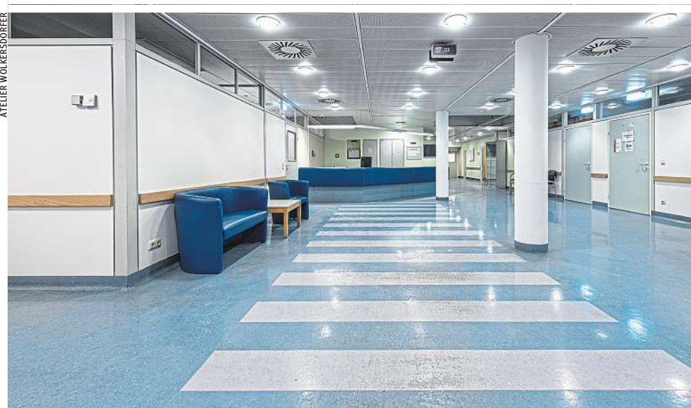
Alpentherme Gastein: Die 1.000 m 2 Linoleumböden im REHA-Bereich waren bis zu 20 Jahre alt. Jetzt scheinen sie durch die Überlackierung wieder in neuem Glanz
