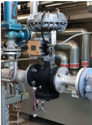
pneumatisches Dampf-Durchgangsventil baelz 340 zur Druckreduzierung
