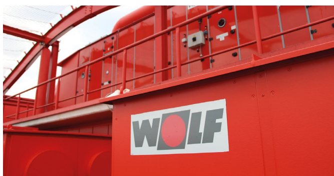
Unauffällig in die Dachkonstruktion eingepasst, steht die Lüftungszentrale auf dem Parkdeck.
