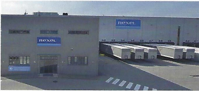
Rexel spart mit Monitoring und Steuerung
