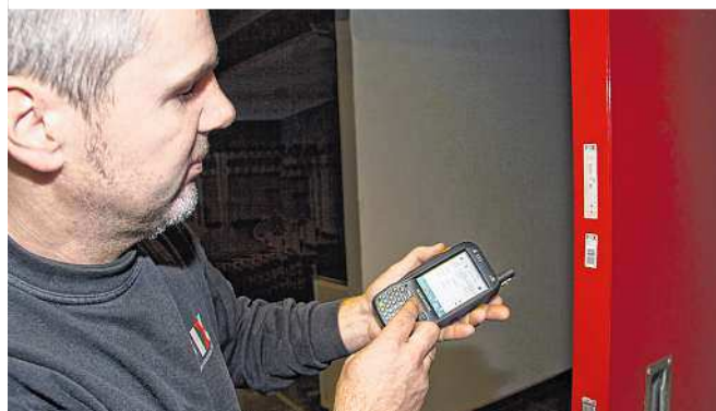
Service und Wartung von Brandschutztoren und -türen
